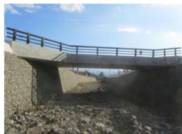
コンクリート橋
