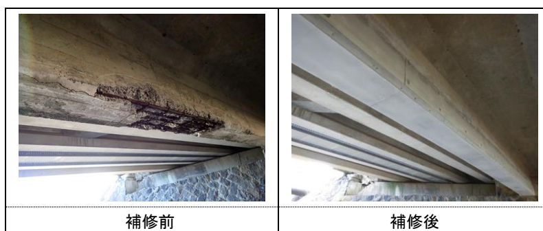
写真 1.1 補修状況写真 (No. 85_山の神橋 主桁の断面修復工)
