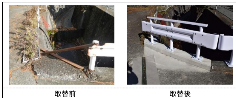
写真 2.4 修繕等の実施例
