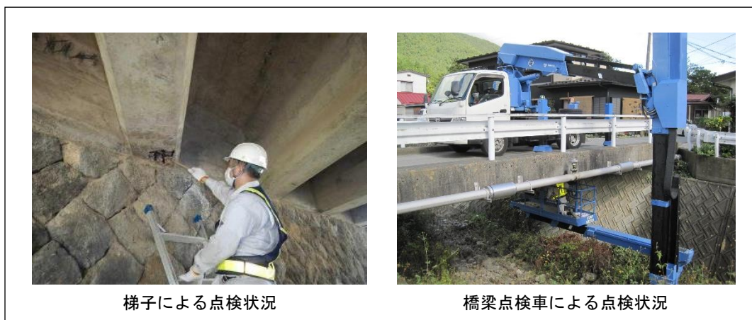
写真 2.2 定期点検状況
