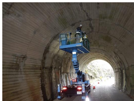
定期点検の状況
