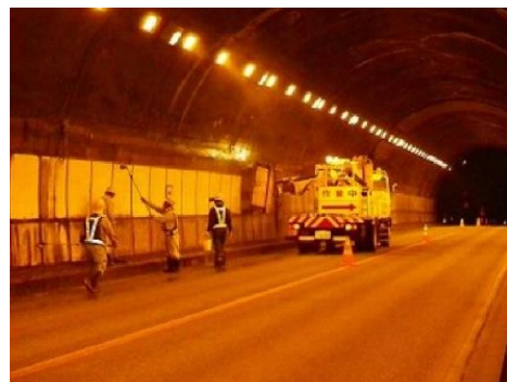
清掃作業の状況
