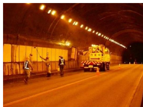
清掃作業の状況
