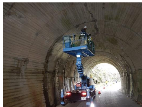
定期点検の状況
