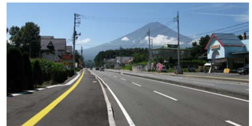
・河口湖大橋通り
