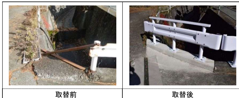
写真 2.4 修繕等の実施例
