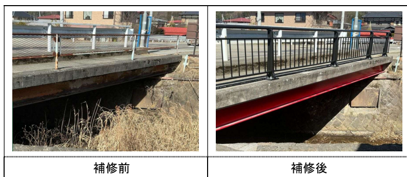
写真 1.1 補修状況写真 (No. 86_寺川橋 主桁の塗装塗替え、高欄の取替え)
