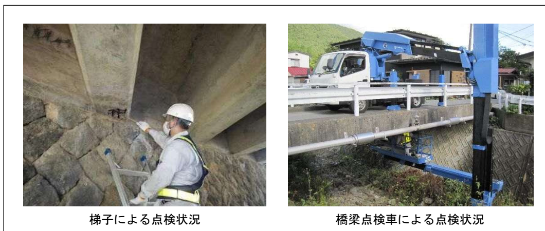
写真 2.2 定期点検状況
