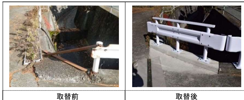
写真 2.4 修繕等の実施例
