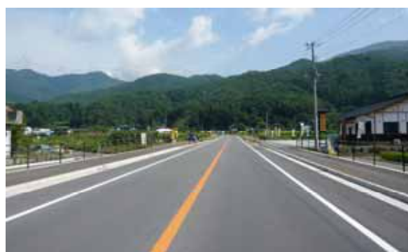
・国道 137 号河口Ⅱ期バイパス
