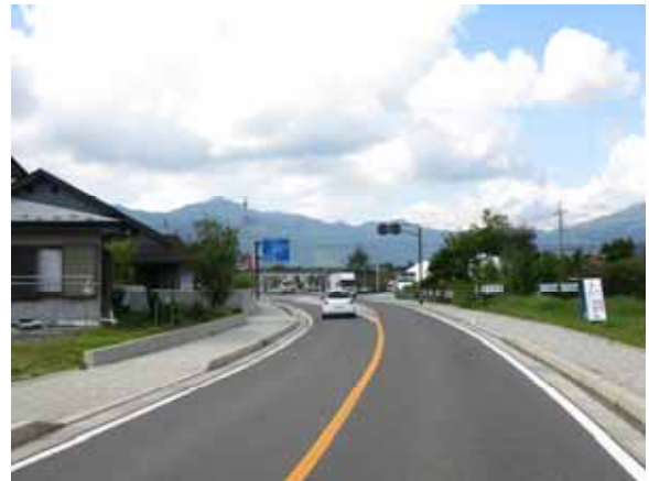
・ 町道河口湖インター線
