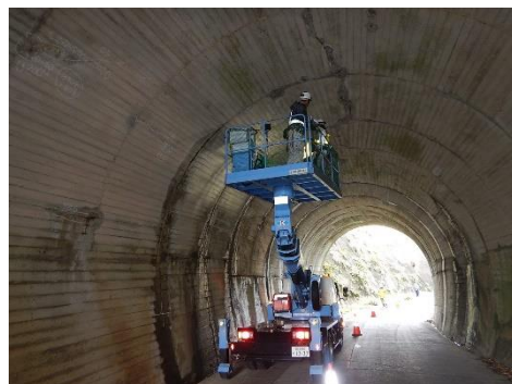
定期点検の状況
