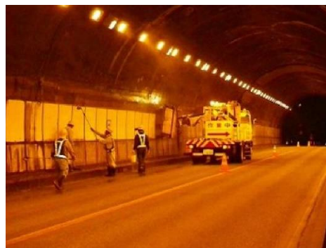
清掃作業の状況
