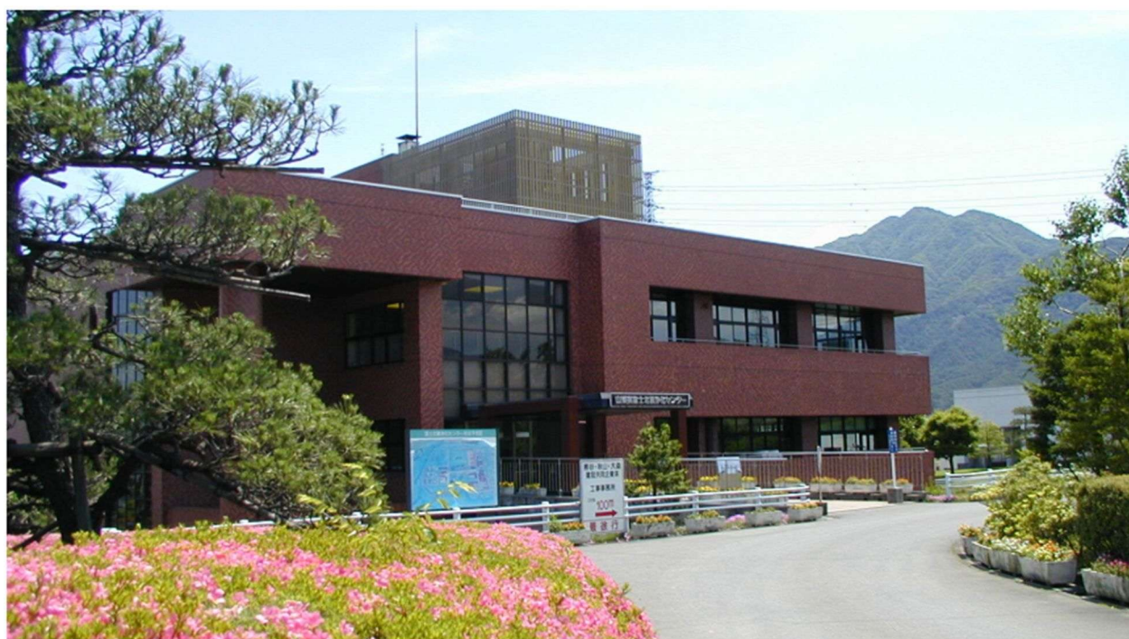
図 2-4-2 富士北麓浄化センター（富士北麓流域下水道）
