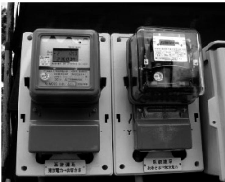
太陽光発電を設置すると買電用と売電用の2つのメーターが付き、発電量と消費量のバランスにより交互に回る
