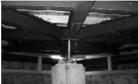
補強された新しい回転軸
