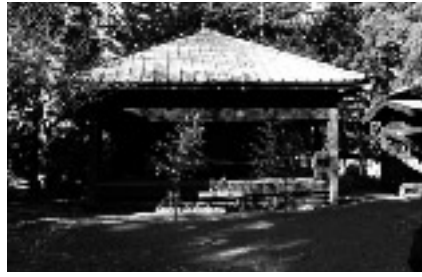
解体工事前の状況
