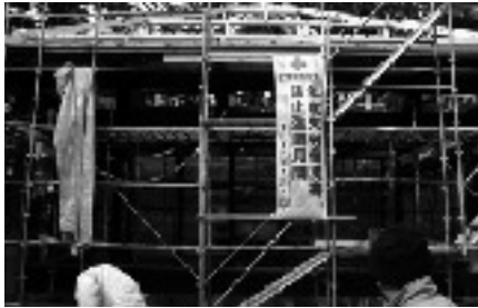
工事中の状況
