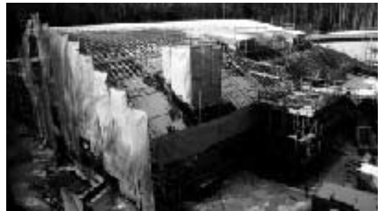
着々と建設が進んでいる新図書館
