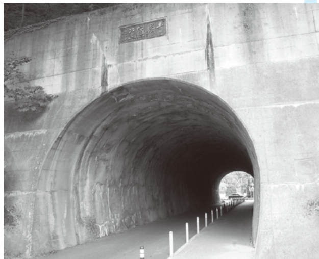
健全であると確認ができた寺崎隧道
