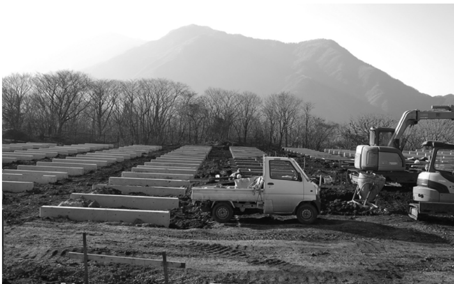
富士ヶ嶺メガソーラー設置工事中
