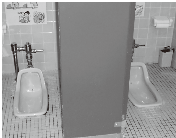
河口小学校和式トイレ
