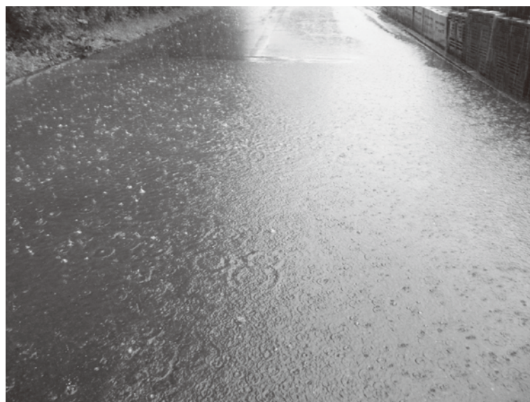
大雨時に道路冠水のひどい町道
