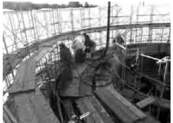
富士ヶ嶺地区貯水槽工事
