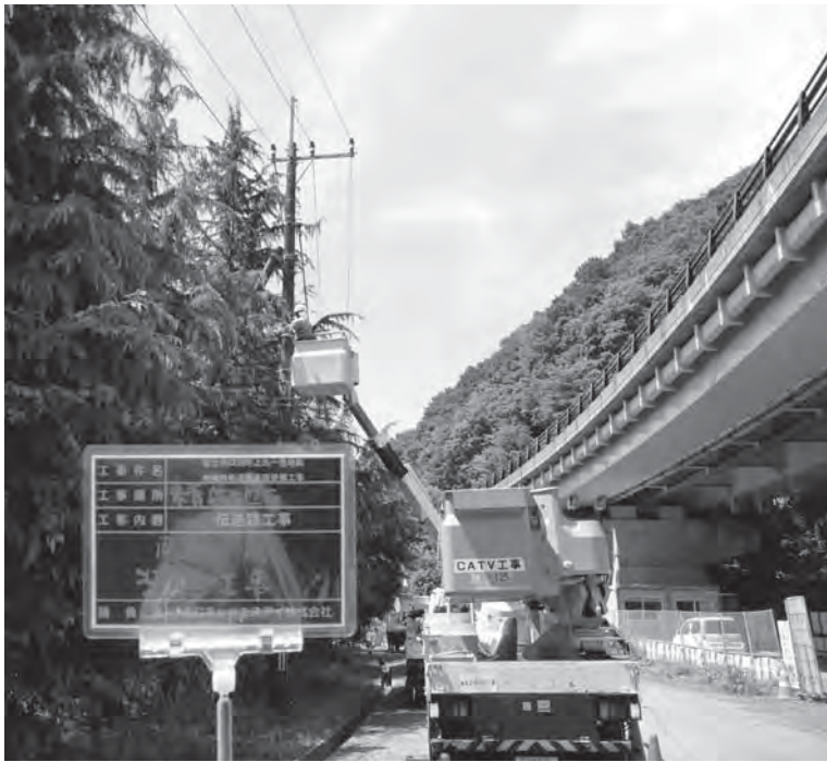
CATV工事（本栖地区）
