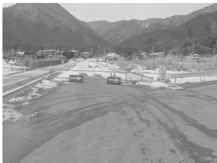
▲ 若彦路道路拡幅工事
