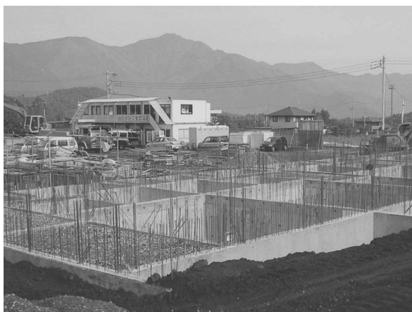
大嵐町営住宅建設現場
