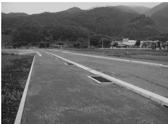
河口Ⅱ期バイパス工事現場
