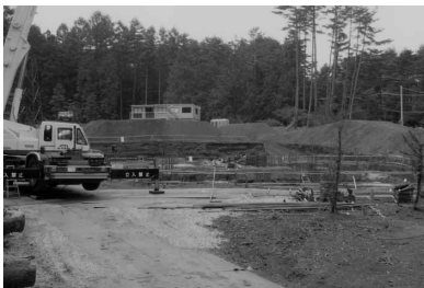
松山油脂株式会社建設現場
