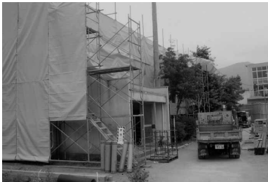
小立小学校体育館耐震改修工事
