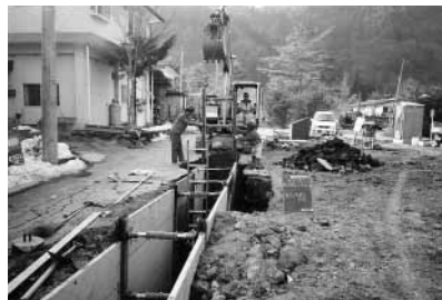
根場地区下水道工事
