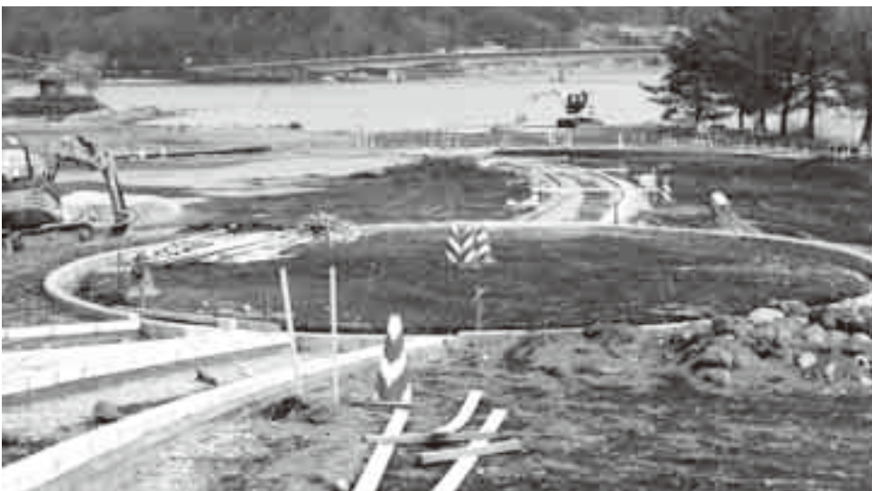
八木崎公園改修工事
