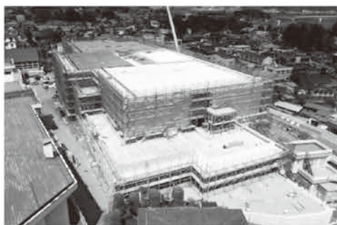
船津小増改築工事
