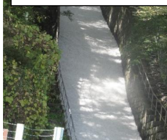
東電うそぶき放水路
