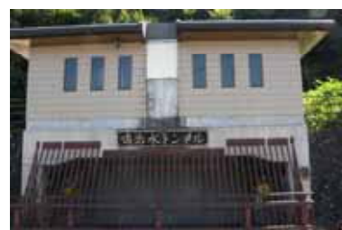
・嘯治水トンネル
