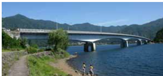
・河口湖大橋
