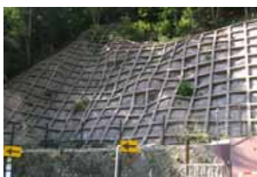
・法面構造物
