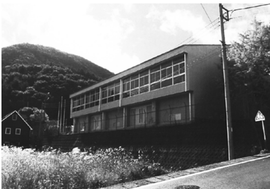
西浜体育館 東面着工前(上)・東面完成(上)
