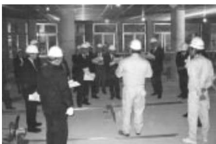
小立小学校建設現場視察
