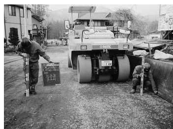
町道改修工事
