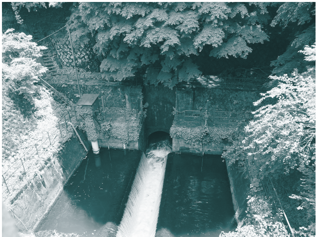
うそぶきすいろうのみくちぶ 嘯放水路呑口部(国登録有形文化財)
