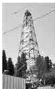
掘削中の第4源泉
