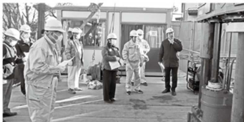
第4源泉工事現場視察の様子(小立)
