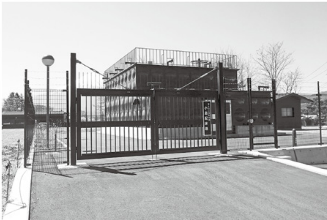
小島配水池(河口)
