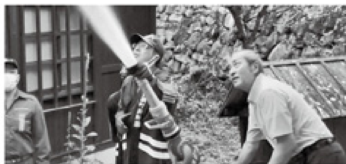
いやしの里に設置してある放水銃
