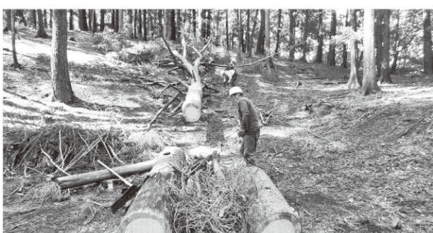
森林整備の状況(勝山地区)
