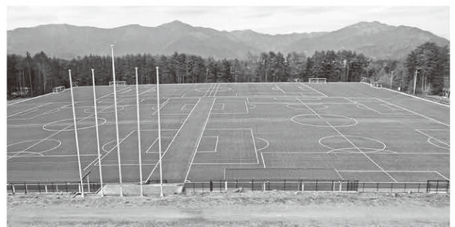
完成した くぬぎ平スポーツ公園人工芝運動場
